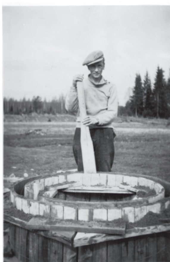
Paavo valamassa kaivonrengasta Sillankorvan pihassa 1954.
