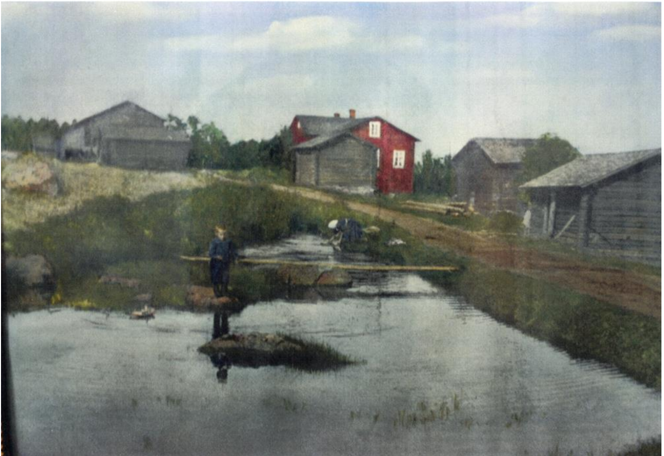
Purossa riitti vettä pyykinpesuun, uimiseen ja leikkilaivan uittamiseen jo oinaspumppua ja sähkölaitosta ennenkin. Myöhemmin väritetty valokuva on vuoden 1910 tienoilta, sillä laivaa uittaa ilmeisesti Tapio, joka on syntynyt 1906, eikä siinä näy vuonna 1927 rakennettua navettaa.
