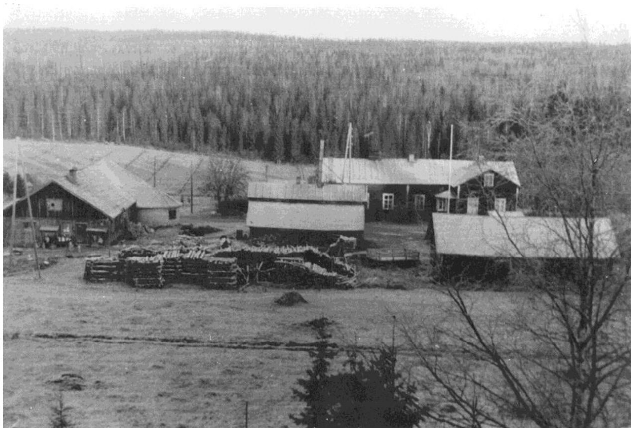
Humalapuron pihapiiri lännen puolelta kuvattuna. Takana päärakennus, vasemmalla navetta.
