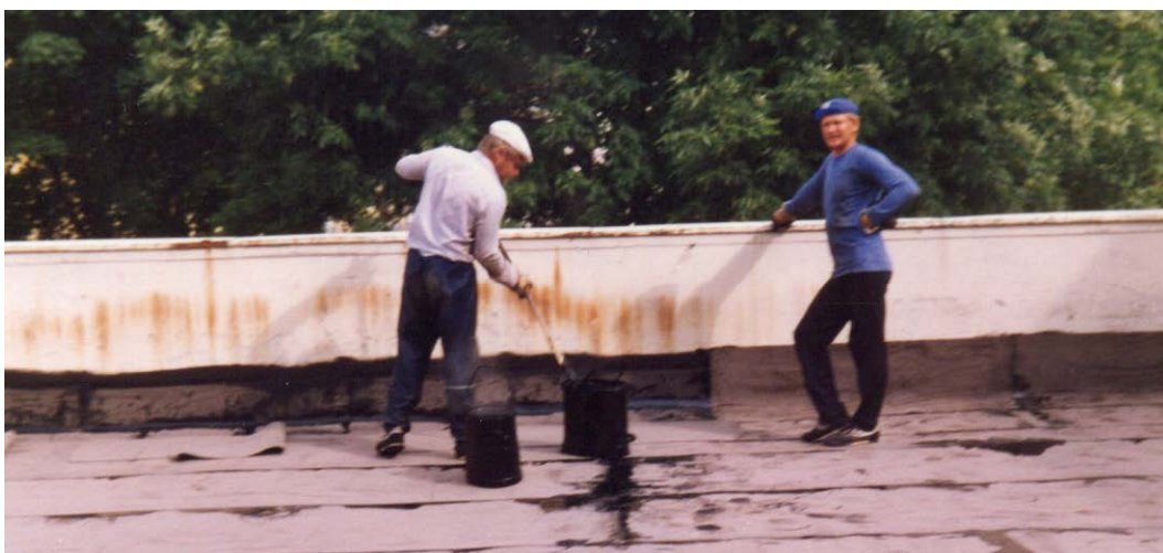
Liikennepihan vesieristystyö Icopal Oy
